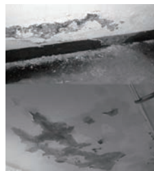
Techos y paredes, filtración de agua en el suelo.
