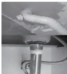
Fuga en el suministro de agua/ Fuga de tubería de agua
